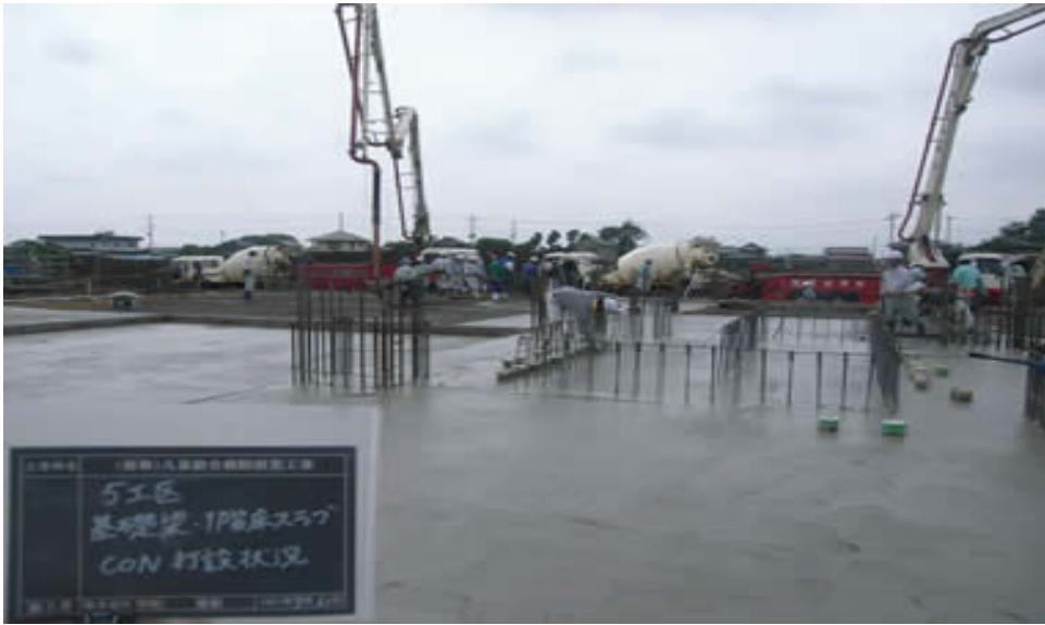
7月31日病棟の1階床基礎梁コンクリート打設状況です。
