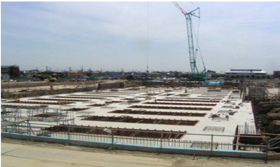
5月15日基礎・梁コンクリート打設状況です。
