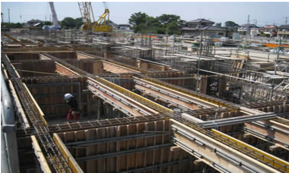
7月16日管理棟基礎配筋型枠の様子です。
