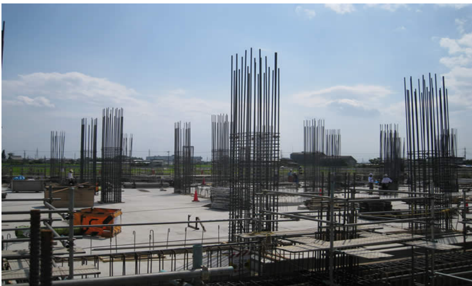
7月16日病棟の工区柱配筋の様子です。
