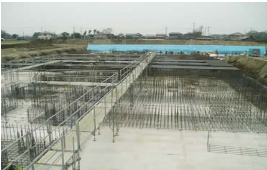
4月4日病棟基礎部分です。
