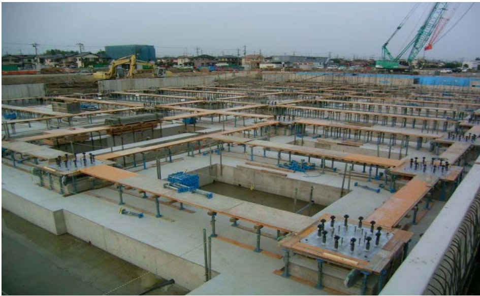
6月4日病棟 免震装置上部 梁型枠組状況です。
