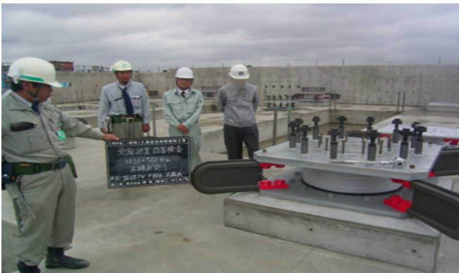
5月29日免震装置ゴム一体型ダンパー設置検査の様子です。
