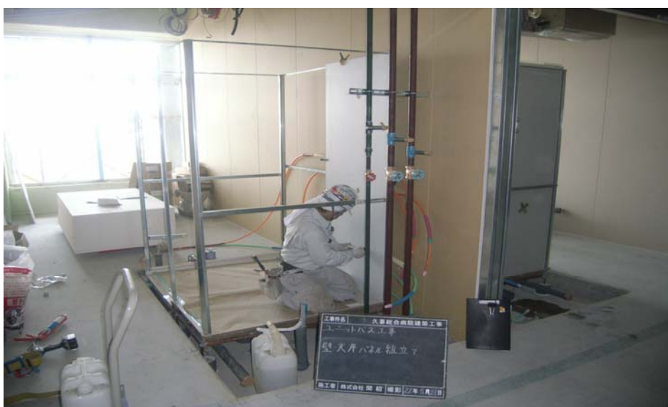
5月22日病棟3階トイレシャワーユニット設置の様子です。
