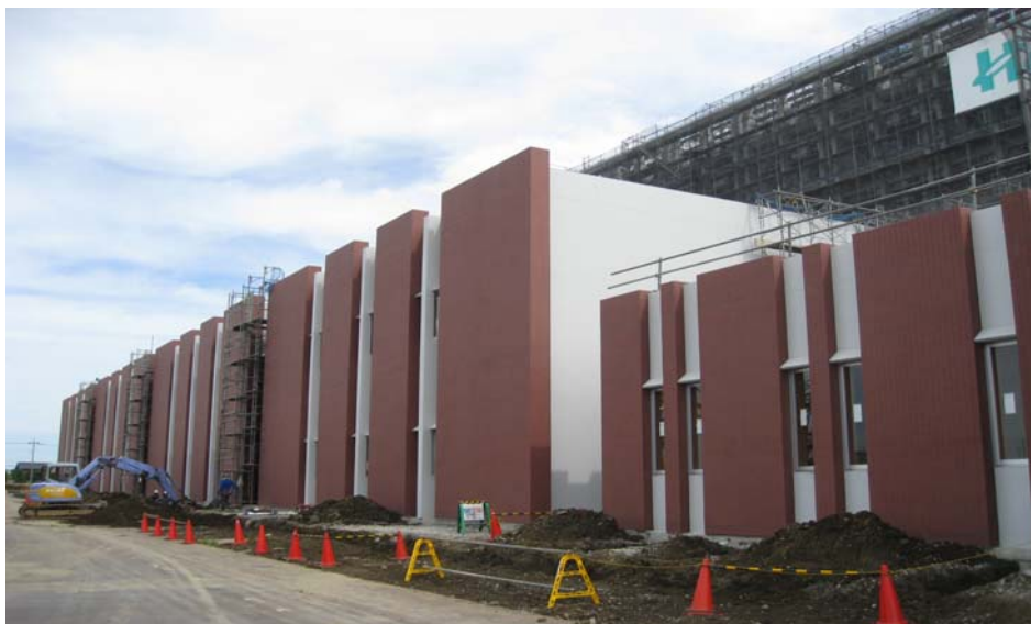
6月24日外来棟の足場が解体されました。
