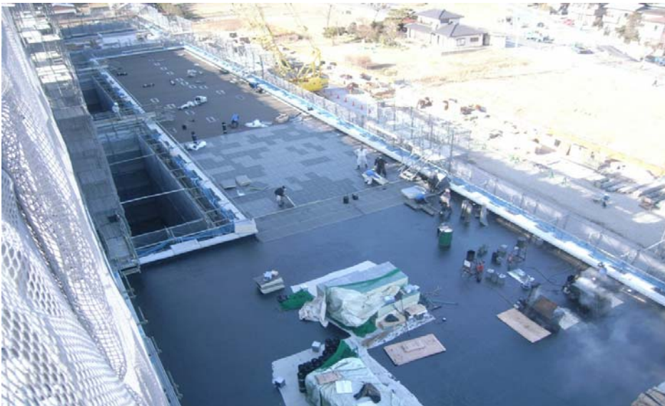
1月22日管理棟屋上アスファルト防水施工状況です。
