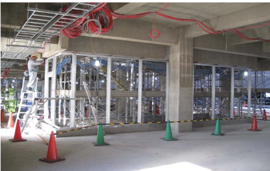
平成22年1月14日外来棟1階中庭 アルミサッシ取付状況です。
