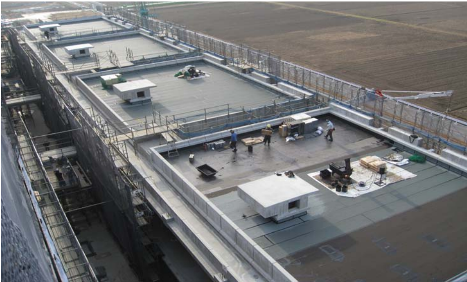
2月23日外来棟屋上アスファルト防水施工状況です。
