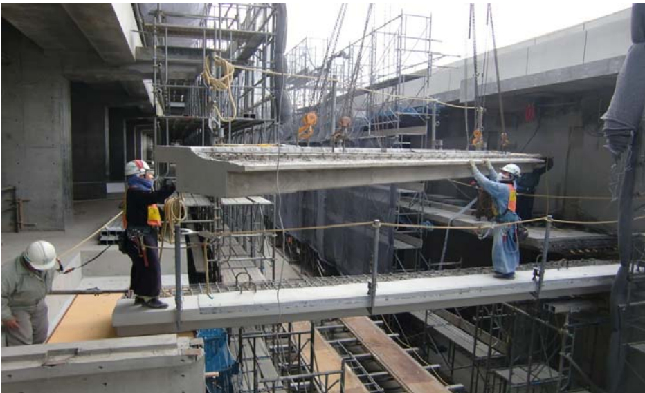
1月28日ホスピタルモール 2階西側ブリッジ取付状況です。
