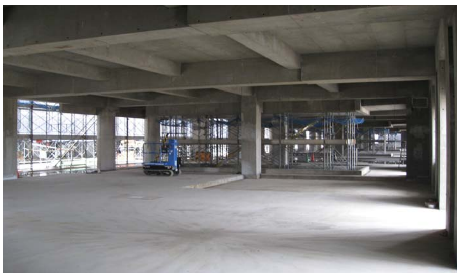
12月16日外来棟の1階型枠支保工解体が完了しました。
