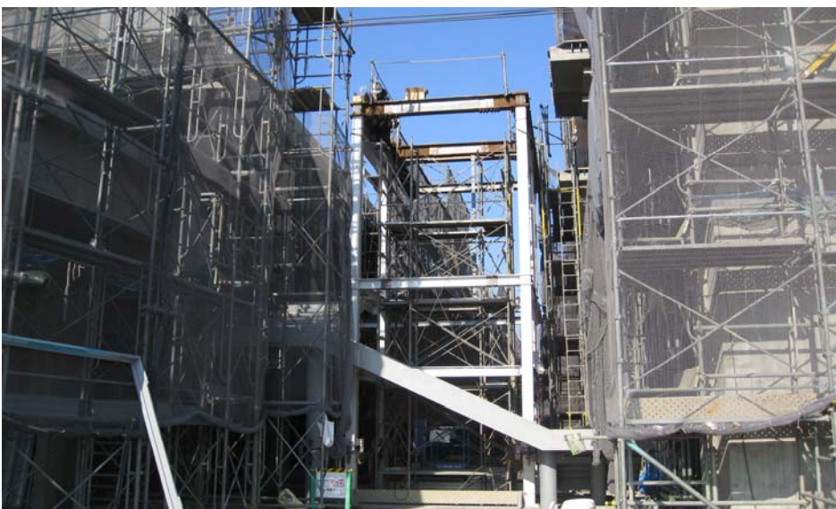
2月20日ホスピタルモールエレベーター鉄骨建方状況です。
